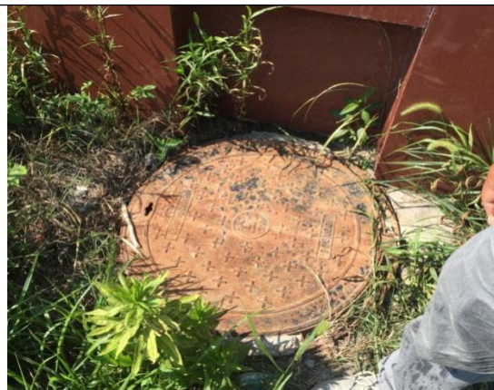
生活污水接管位置
