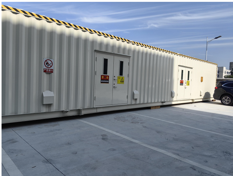
危险废物暂存间
