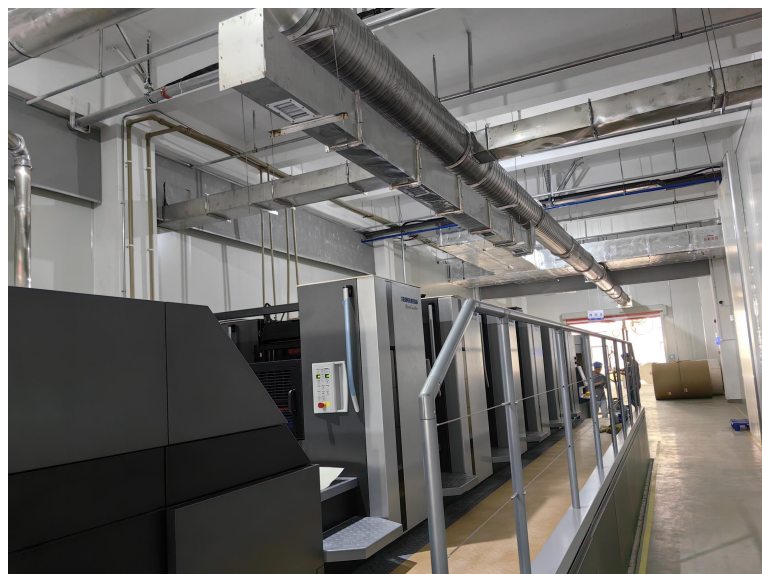
废气收集设施
